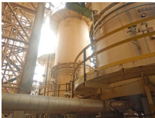
Gambar 1. Furnace berkapasitas 2557 pada Naptha Hydrotreating Unit
