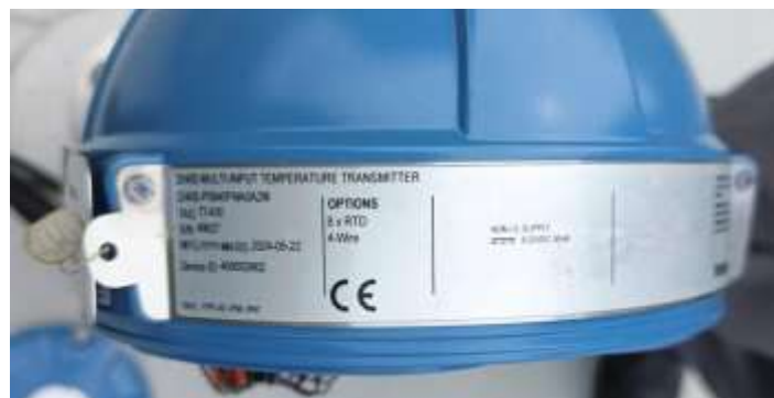
Gambar 4. Nameplate Rosemount 2240S pada tangki ATD-T-10026
